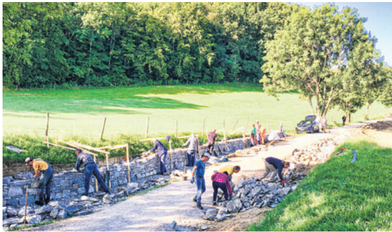
Exaktes Arbeiten hat Priorität
